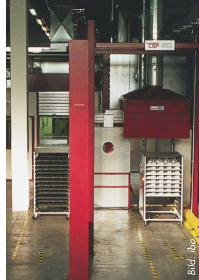
Links: Einlauf in die Hordenwagenschleuse zur Aufgabestation Rechts: Auslauf der Hordenwagen aus dem Trockner mit Bereitstellung zur Kontrolle und Verpackung.
